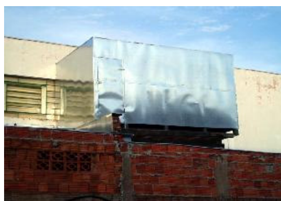
Fig. 01b – Barreira pronta em volta do sistema de refrigeração.
